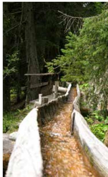
Dieser Holzkanal gehört zum «Aual Foppumvasch» bei Guad. Derzeit fliesst dort leider kein Wasser, weil die Kanäle von einem Steinschlag stark beschädigt wurden.
